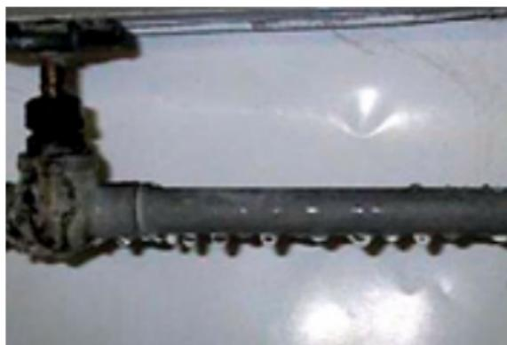
Se o ar for expandido, a sua capacidade de retenção de água em forma de vapor aumenta, em contra partida, a quantidade de vapor que ele pode reter diminui se for compactado.
